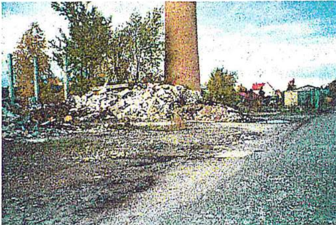
Blick auf das zerstörte Heizhaus aus südlicher Richtung. Der Hauptteil der Trümmer und die Gehölze befinden sich außerhalb des Plangebietes.
