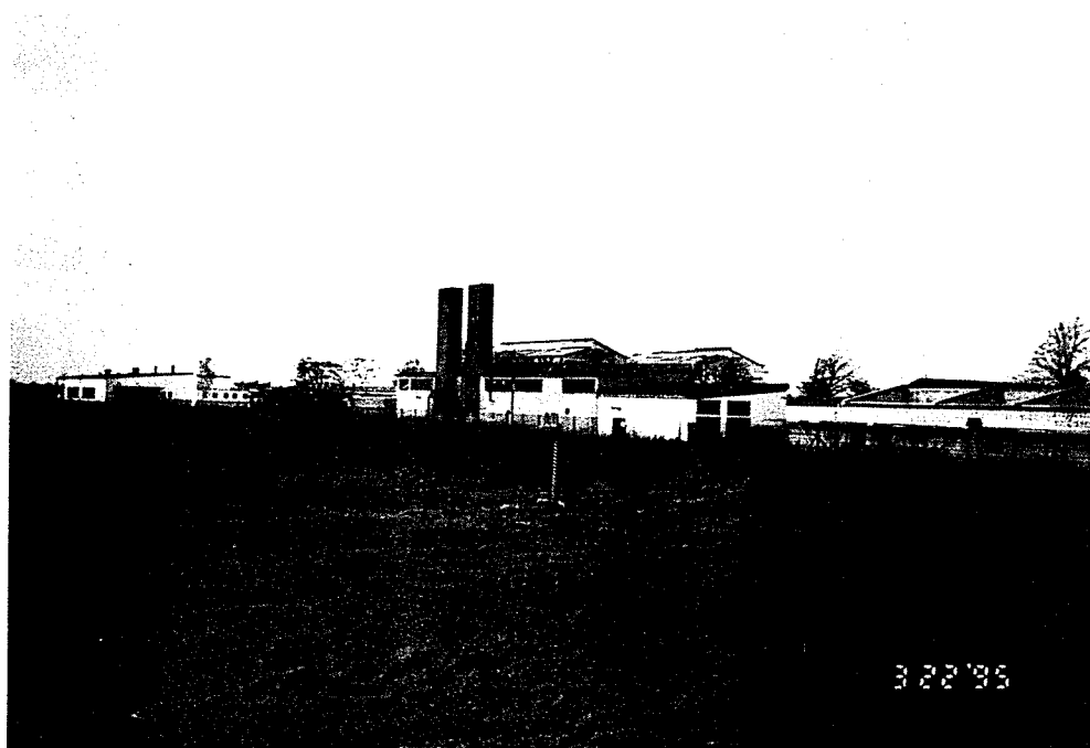
östlicher Teil des Plangebietes - bauliche Anlagen des Bundeswehrkrankenhauses
