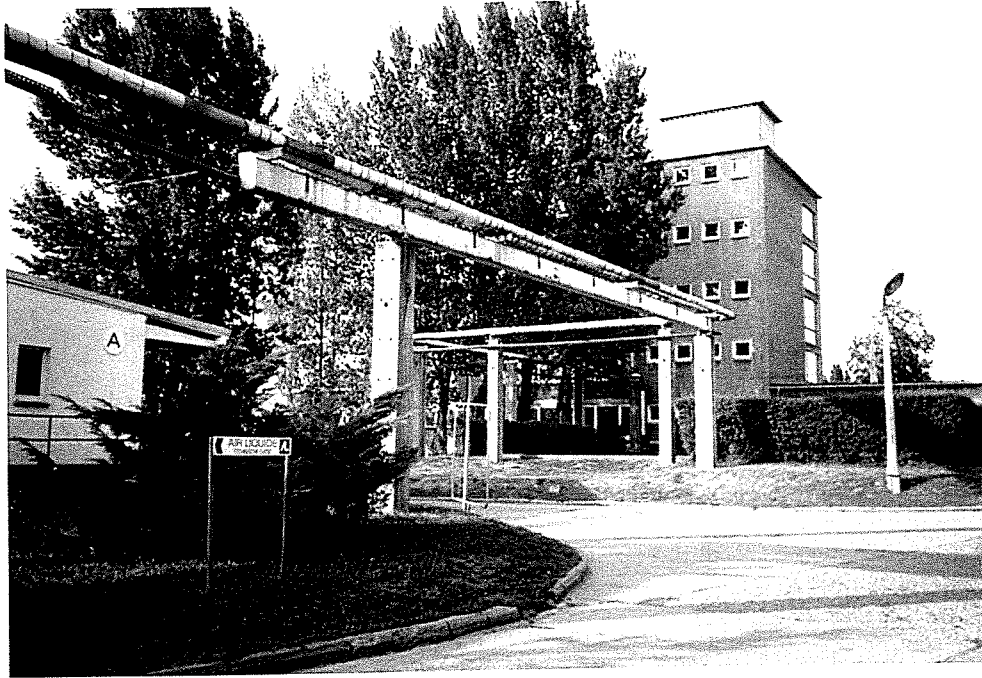
Bild 1: Der Eingangsbereich des ehemaligen Chemiehandels. Vor dem Verwaltungsgebäude sind die mittelalten Pappeln zu erkennen. Die Grünflächen sind in diesem Bereich intensiv gepflegt.
