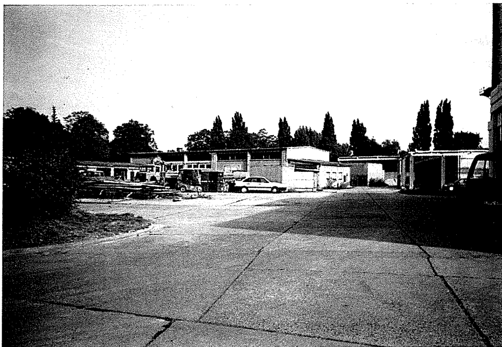
Bild 2: Große Teile des Geländes des ehemaligen Chemiehandels sind mit Beton versiegelt
