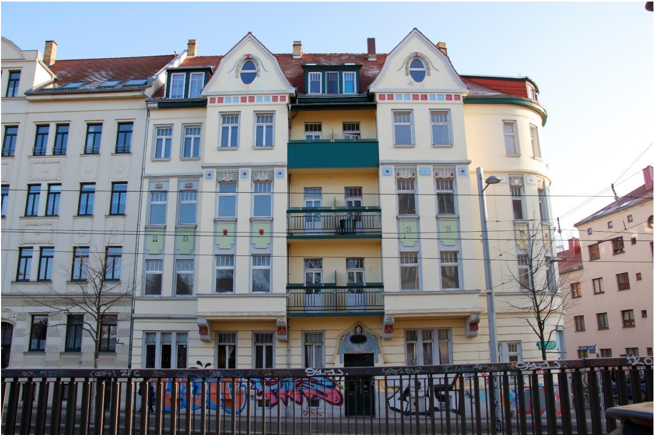
Bild 15. Von Dacherkern bekrönte Erkerbänder flankieren Balkone, Lützner Straße 111.
