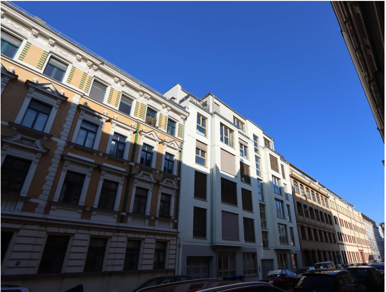
Bild 23: Erhaltungsrechtlicher Fremdkörper, der die vorgeprägte Trauflinie sprengt und dessen zu wenig zurückgesetztes Staffelgeschoss den Effekt massiv verstärkt, Erdmannstraße 14
