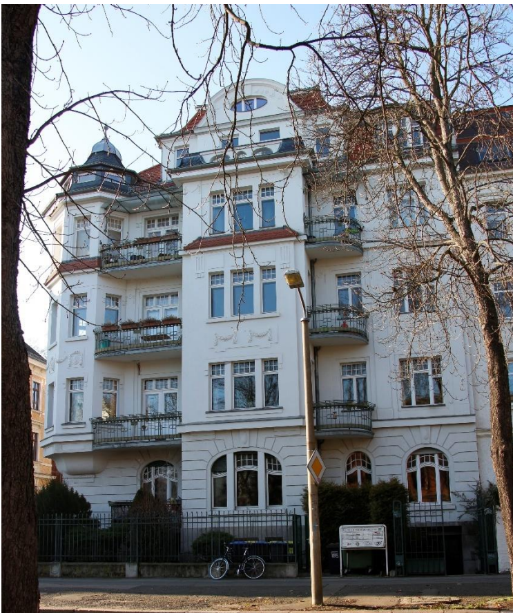
Bild 14: Von Balkonen flankiertes Erkerband, Polygoneckerker, Erich-Zeigner-Allee 34, Ecke Amalienstraße.
