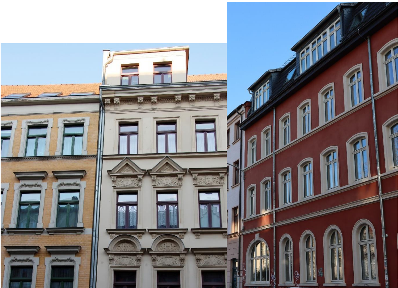
Bild 8: Typische Fenster mit t-förmiger Binnengliederung in der Henriettenstraße 8 und 6 (links), klassizistische Form mit Segment- und Rundbögen in der Weißenfelser Straße 33 (rechts).
