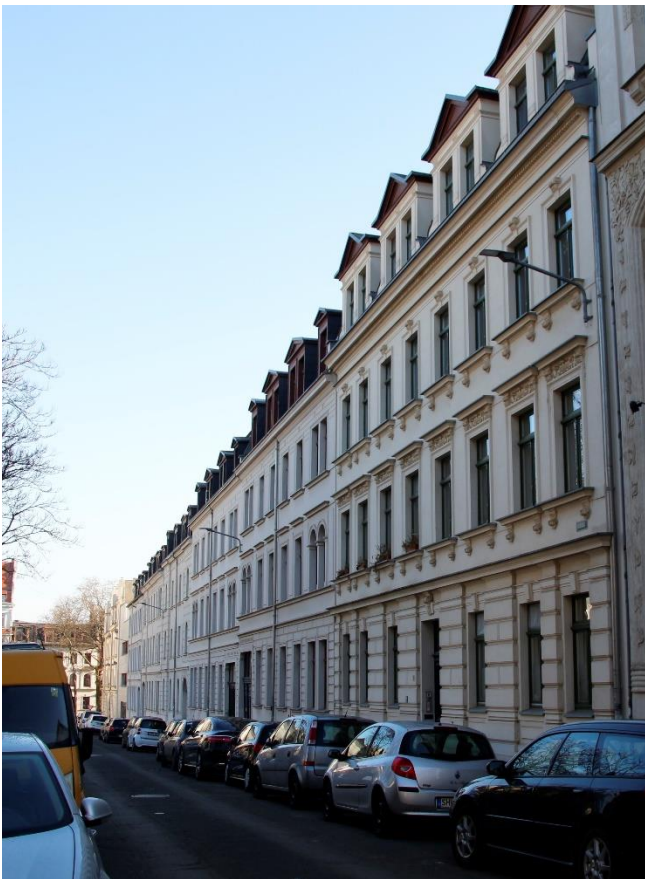
Bild 21: Die Trauflinie einhaltende Flachdächer mit abschließendem Kranzgesims in der Merseburger Straße 36 und 34.
