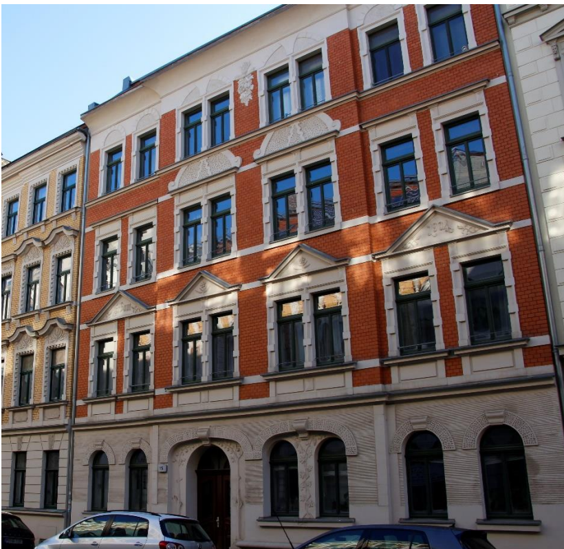
Bild 10: Mittelrisalit über 2 Fassadenachsen, Erdmannstraße 15.
