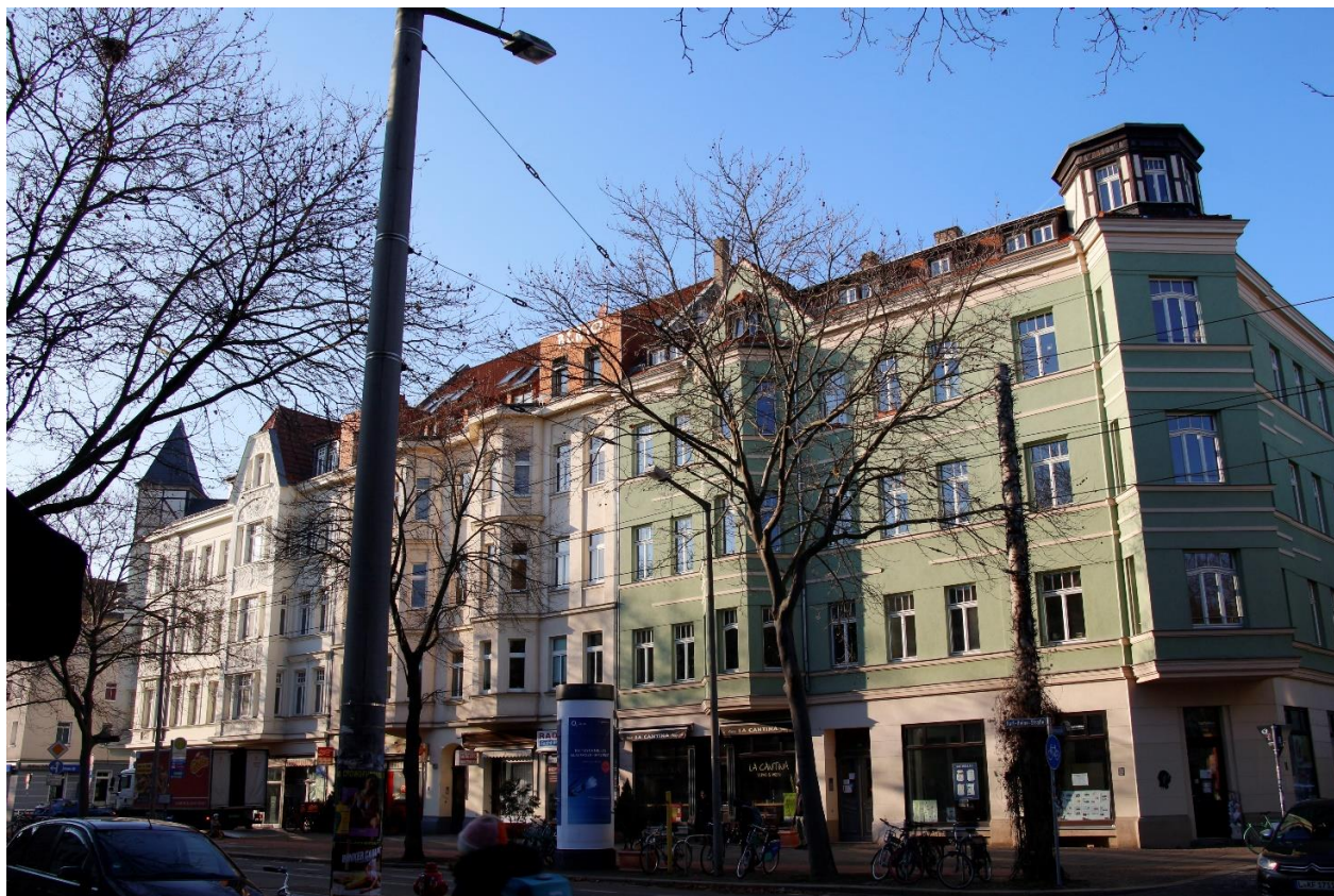
Bild 18: Dachgauben und -erker sowie Turmhelmgedekte Eckdacherker. an der Karl-Heine-Straße 56b, 56, 54 (von links nach rechts).
