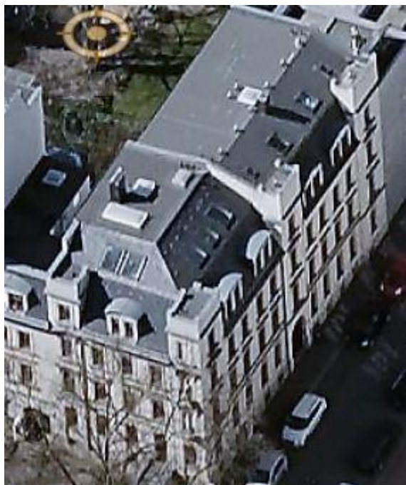
Bild 19: Liegende Fenster im 2. Dachgeschoss des Mansardpultdachs Erich-Zeigner-Allee 30, Ecke Amalienstraße. Quelle: Stadt Leipzig, in Kooperation mit GeoFly GmbH
