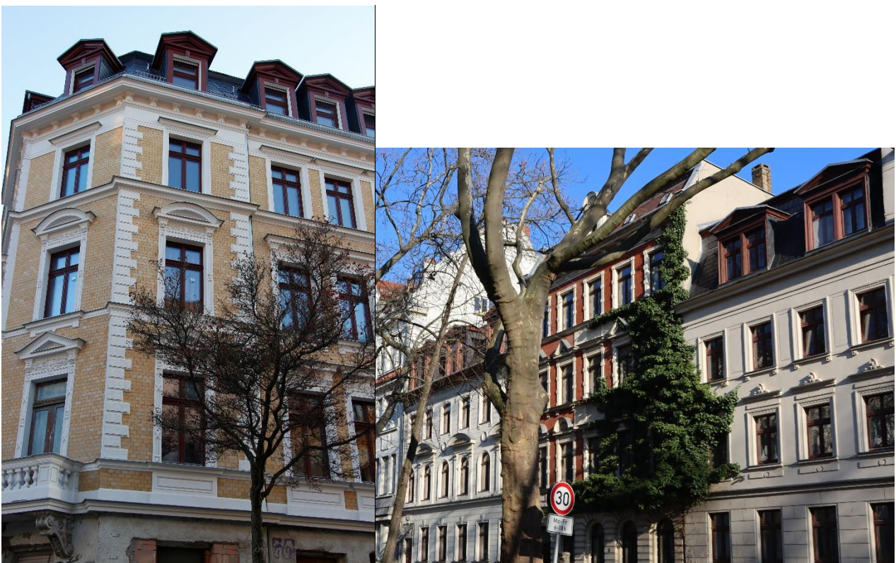
Bild 16: Mansardpultdach an der GutsMuthsstraße 38 und Erich-Zeigner-Allee 39 (mittig).
